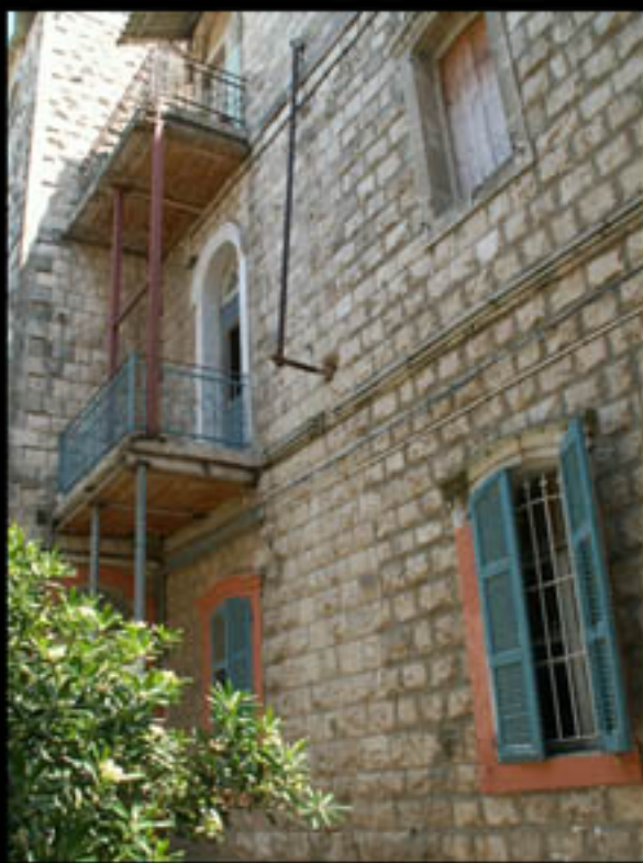
המרפסות הקונזוליות ייתמכו לשחזור מרבי של מצבן המקורי ולהסרת עמודי המתכת הארעיים
